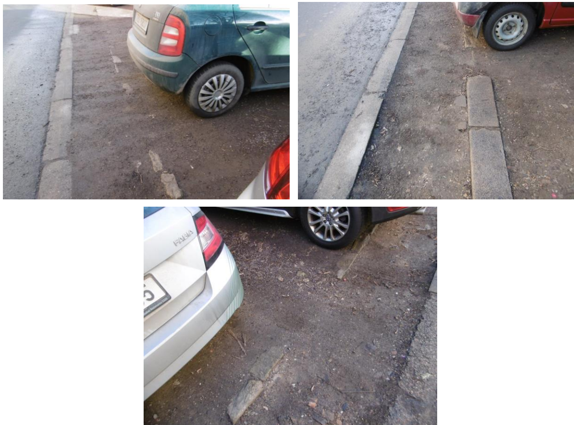
Pohled na část parkoviště, kde je vidět „druhý“ obrubník v parkovací ploše, který bude také odstraněn, aby mohla být položena propustná dlažba.
