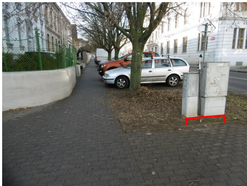
Pohled na konec parkoviště, kde se nebude parkovat. Bude zde pouze odstraněna vrchní vrstva cca 20cm a po dokončení stavby bude navezena ornice a vše nově zatravněno. Pouze na vyznačené části bude položena zámková dlažba, aby byl přístup k technické infrastruktuře.
